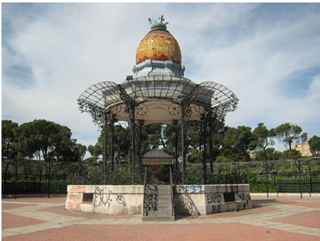
Zaragoza. Quiosco de Música para la Exposición Hispano-Francesa, 1908. Utilización de columnas de fundición.
