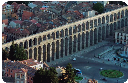
Acueducto de Segovia, siglo II d. C.
